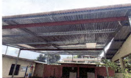
Foto 9: Láminas en el techado del patio lateral.
