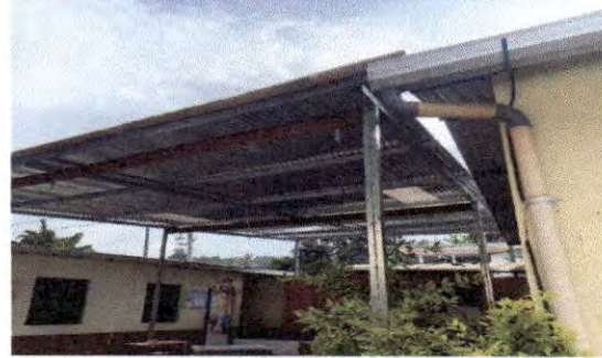
Foto 11: estructura portante de metal con signos de corrosión.
