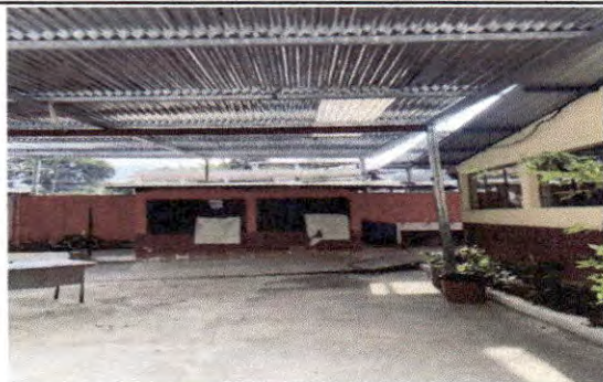
Foto 7: lamina en mal estado y con signos de corrosión.
